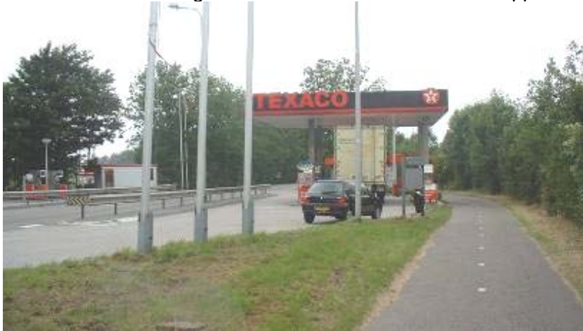
Figuur 6: Het benzineverkooppunt aan de Provincialeweg
