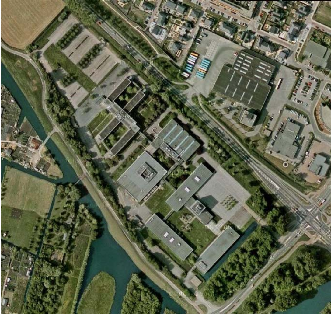
Figuur 2: Luchtfoto Park Krayenhoff, voordat de bedrijfspanden zijn gesloopt.
